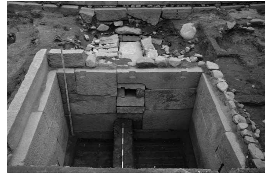
↑ D区で見つかった集水枡と排水路(西から)
