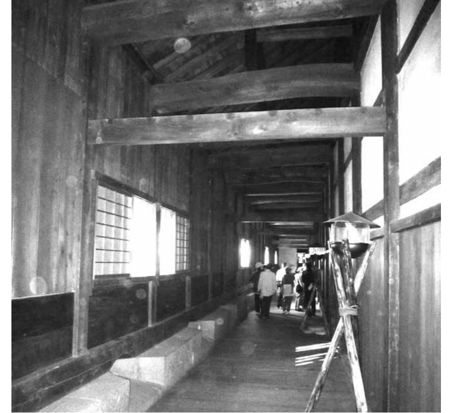
↑ 大手口に現存する多間櫓の内部
