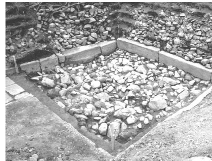
図9 区裏込石の状況
